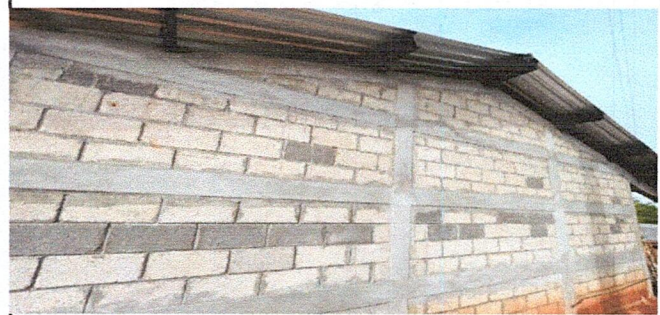
Foto 4: Pared exterior de escuela.
